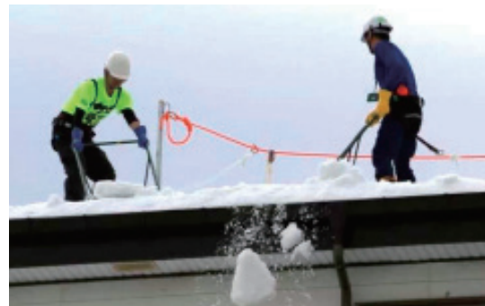
命綱、ヘルメットを装着して作業する様子（提供：新潟県）
